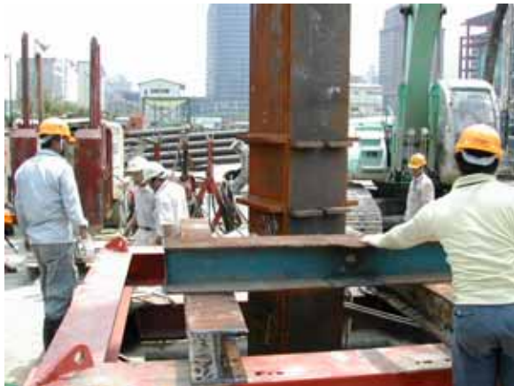
逆打鋼柱吊放至欲放置水中千斤頂椅座處，並放置H型鋼以利後續調校逆打鋼柱作業。
