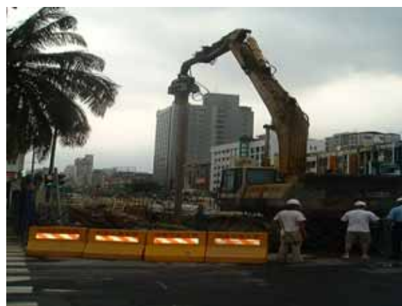
單獨式鋼板樁打設，將每片鋼軌樁一次直接打入至預定深度
