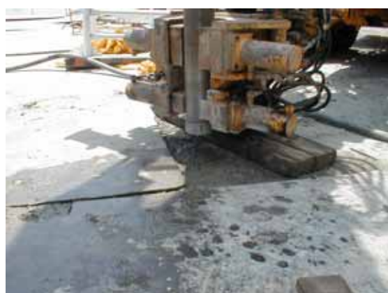
鑽機組裝及定位：鑽機架設完成後準備鑽孔。
