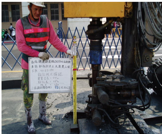
鑽孔深度確認：利用量尺做確認
