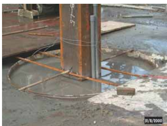
混凝土澆置後，上方空打部分回填完成，將逆打鋼柱用鋼筋臨時固定。
