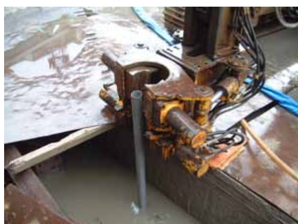
回填與封層：拔除套管後情況
