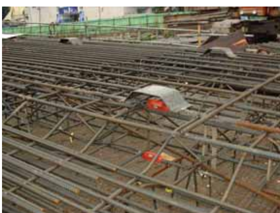
裝設後保護措施：裝設護耳保護設施，避 免因吊放鋼筋籠時碰撞 導溝而損壞
