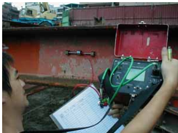
觀測初始值：支撐吊裝完成後，施加預壓前後利用電纜延接至資料記錄器量測初始值
