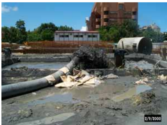
反循環鑽掘抽出之泥水經由吸泥管排至沉澱池。
