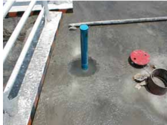
孔壁管間回填：裝設完成之壁體外傾度管
