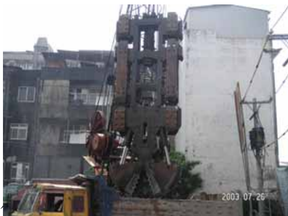
挖掘機打開抓斗將挖出之土壤倒入運土車中
