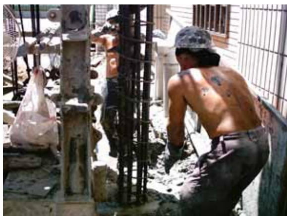
利用吊車將已組立完成之鋼筋籠植入 砂漿樁體內
