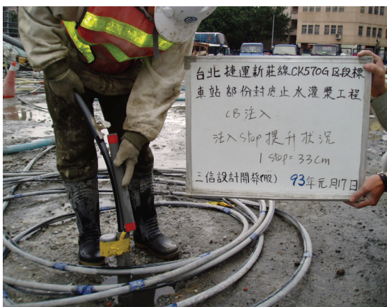
低壓灌漿：灌注時每階段提昇 33 公分
