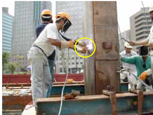
水中千斤頂椅座安裝，以便後續將水中千斤頂固定於逆打鋼柱上。
