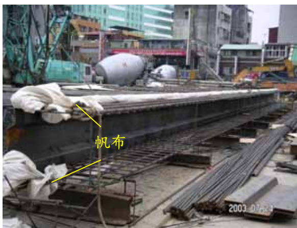
母單元鋼筋籠端版兩端繫上帆布
