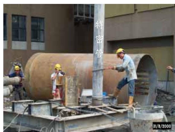
逆打鋼柱定位及清除底泥後，吊放特密管準備澆置混凝土。
