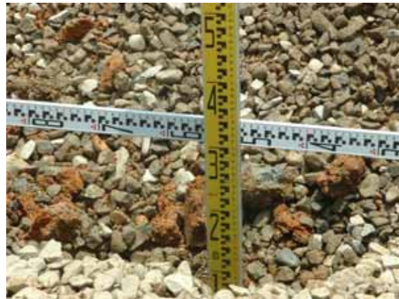
鋪設厚度 30cm 以上之透水碎石覆蓋排 水管。
