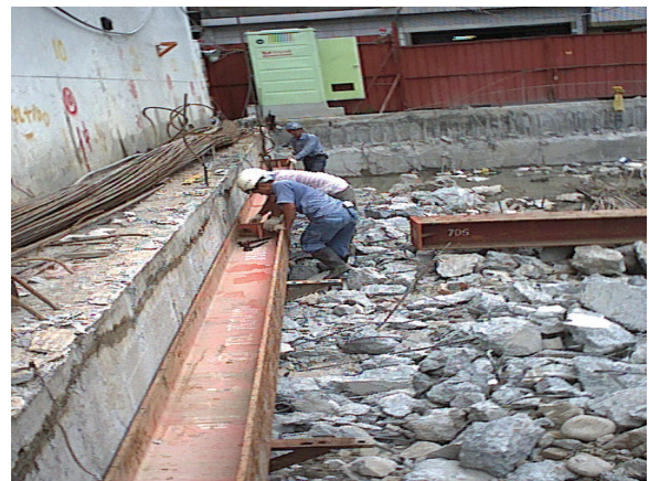
水平支撐圍苓裝設(擋土設施為連續壁)
