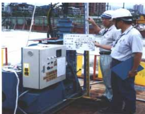
鑽孔深度確認：以鑽桿根數及長度做深度確認
