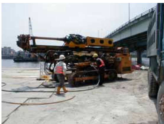
鑽機組裝及定位：將鑽機移至設計鑽孔位置
