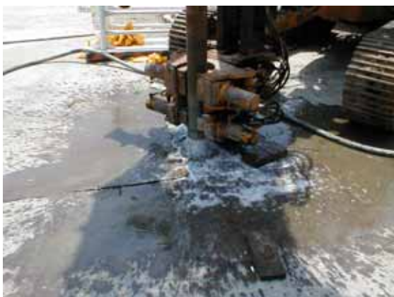
洗孔至設計深度：鑽孔過程同時，保持 水柱向套管中沖洗
