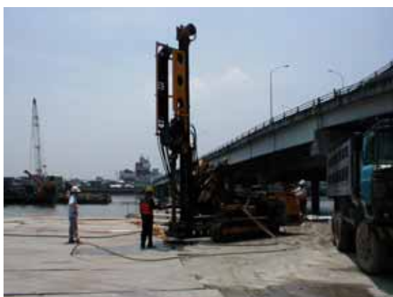
鑽機組裝及定位：鑽機水平，並利用水準器確認鑽機平整度
