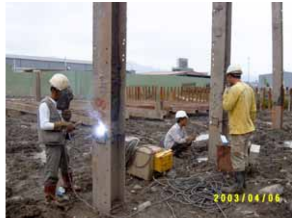
中間柱接樁焊接
