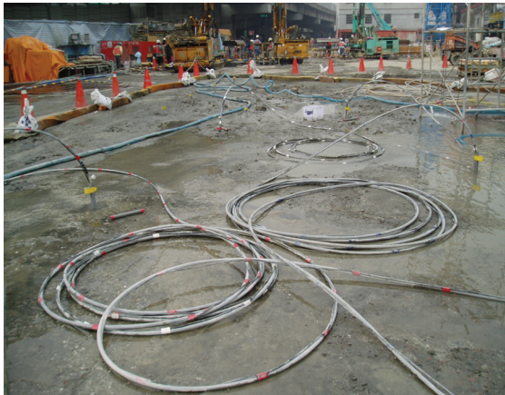
低壓灌漿：現場灌漿情形
