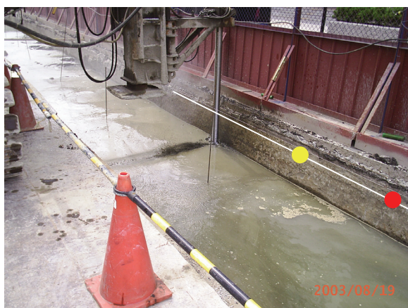
鑽機定位：利用鑽桿對準灌漿孔位
