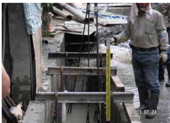
測量鋼筋籠吊放之水準高程。
