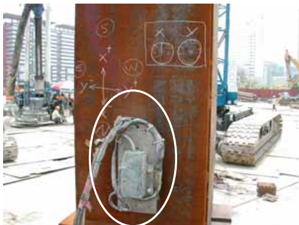
將角度檢知器安裝於逆打鋼柱上，用以檢測逆打鋼柱是否傾斜。
