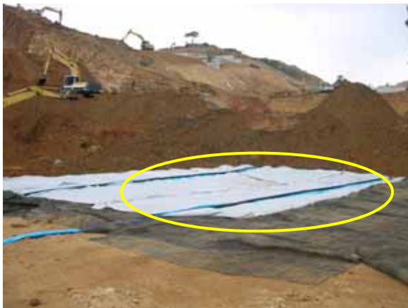
依設計圖設置包覆不織布之水平排水 管,下方沿管線鋪設不透水帆布。
