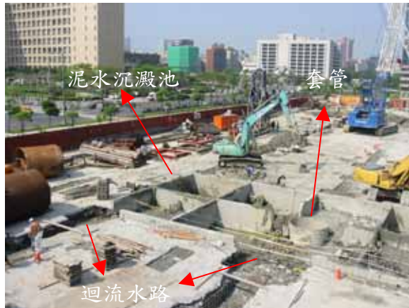
反循環鑽掘基樁沉泥池及迴流水路。
