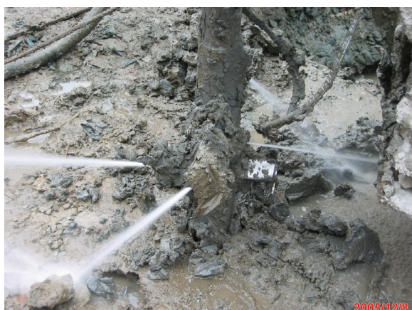
拌合刀鑽至設計深度：利用高壓水，向下旋轉至設計深度
