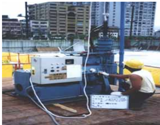
鑽孔深度確認：以量尺做深度確認
