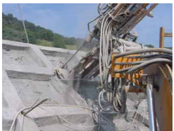
乾鑽時利用空氣壓力，清除孔內殘渣
