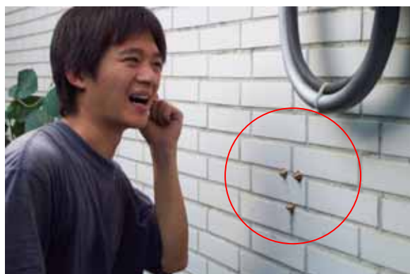
電鑽鑽孔：為了不要造成壁面龜裂與剝落，可在磁磚交界面處鑽孔
