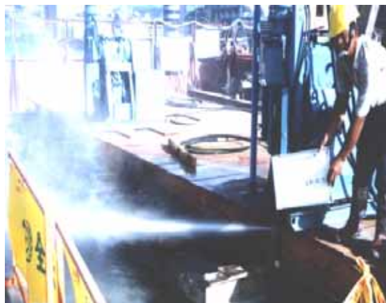
預灌噴射：確認噴射壓力
