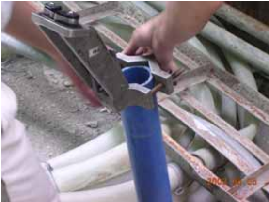
孔壁管間回填：將塑膠管慢慢由孔底向上拔昇
