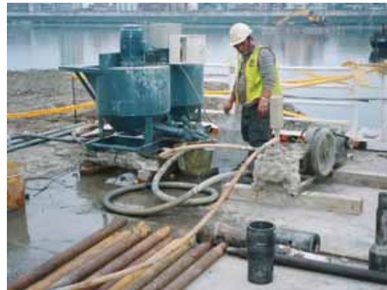
孔壁管間回填：利用拌合機，依設計比例混和水泥、皂土與水
