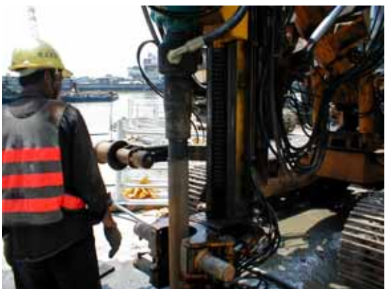
鑽機組裝及定位：加長套管，增加鑽孔 深度
