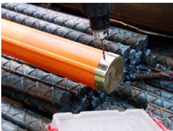
傾度管裝設：裝設管底保護蓋，並打設鉚釘及纏繞防水膠帶
