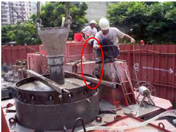
以水尺隨時量測混凝土澆置深度
