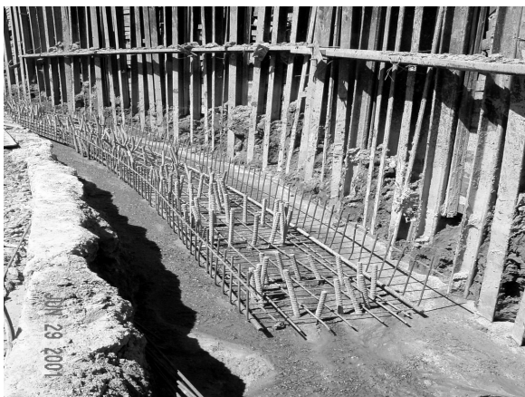
排樁頂部之預留鋼筋需與壓樑鋼筋接 合綁紮
