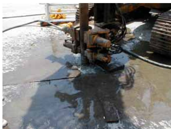
鑽機組裝及定位：鑽機上下震動連帶旋 轉鑽頭，以便增加鑽孔效率
