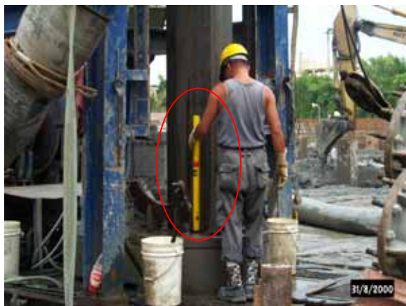
反循環鑽掘機鑽桿垂直度檢測。
