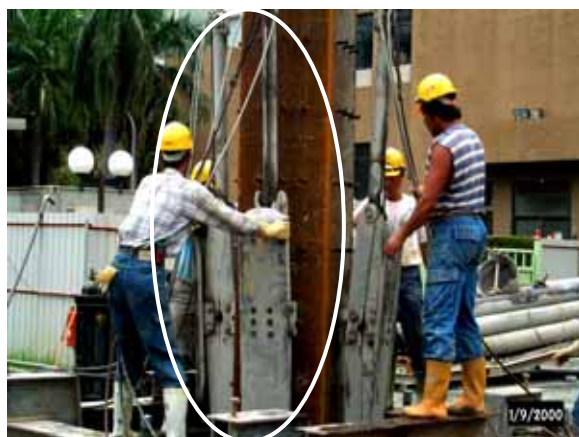
將水中千斤頂安裝於預先電焊在逆打鋼柱上之椅座，水中千斤頂使用完後，可由地面回收。
