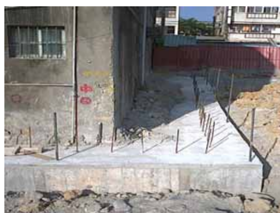
壓樑施做完成，也可阻擋地面水流入開 挖面
