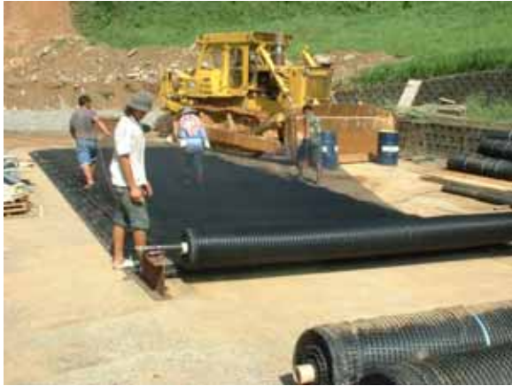
依照基礎設計之寬幅,決定格網裁剪長度。
