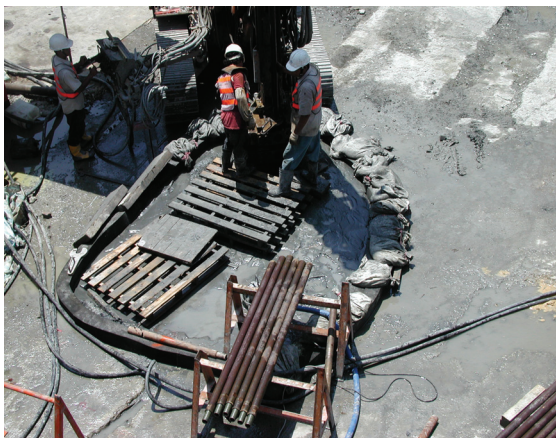
鑽孔至設計深度：依設計鑽至規定深度
