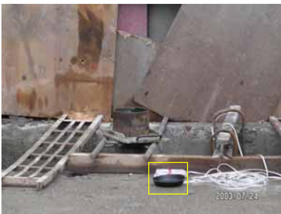
澆注混凝土前，事先在特密管中丟入橡皮碗。
