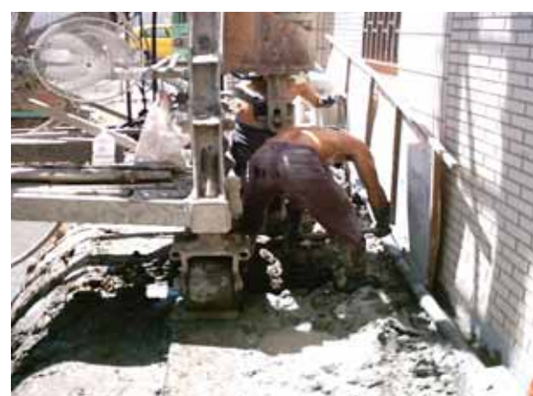
鑽桿提升灌注砂漿，並將附著於鑽桿泥土清除避免事後處理不便
