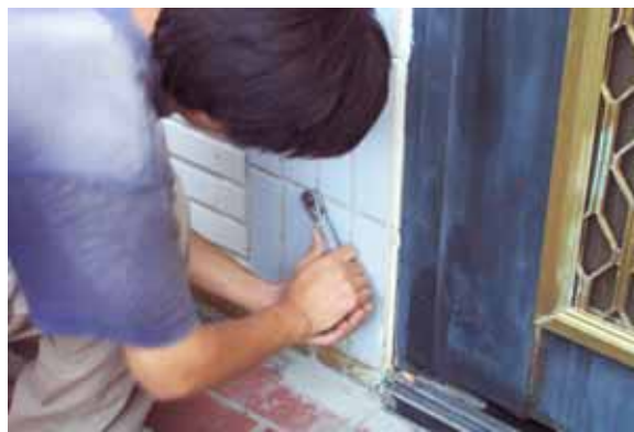
鑽孔及安裝：鎖緊建物沈陷點的膨脹螺栓
