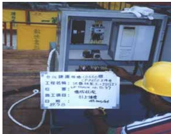
灌漿參數檢驗：鑽桿提升速度測定（碼錶）
