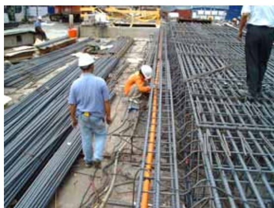
傾度管裝設：傾度管裝設平行於主筋
