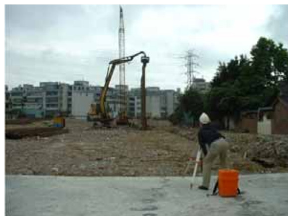
利用經緯儀檢核鋼板樁打設垂直度
