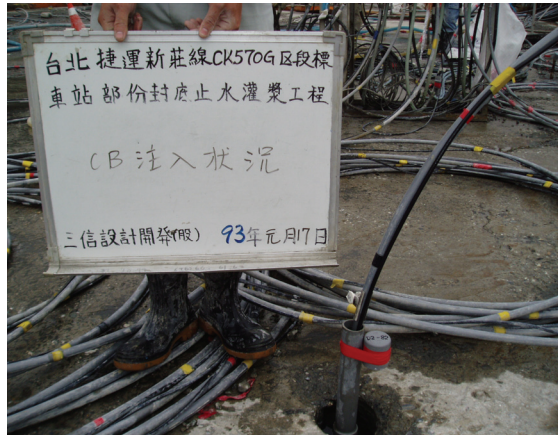
低壓灌漿：CB 液注入狀況
