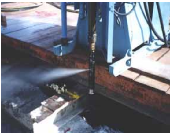
洗孔至設計深度：利用鑽孔水，向下旋轉至設計深度
