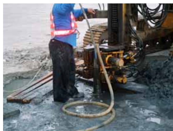
孔壁管間回填：利用塑膠管，由孔底向上灌漿
