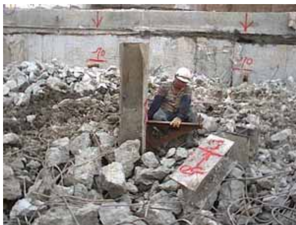
中間柱三角托架裝設
