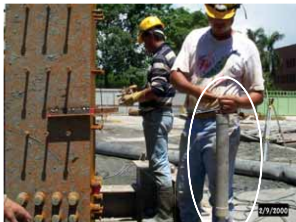
安裝的浮筒可用於檢測逆打鋼柱之垂直度，配合水中千斤頂調整之。
