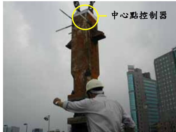
逆打柱吊放至定位，圖中為露出地表之假柱
