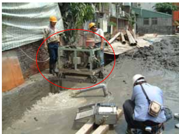
超音波檢測開挖壁面形狀及坍孔情形
