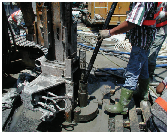
鑽孔至設計深度：安裝外灌漿管
