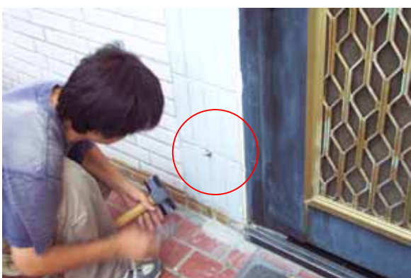
鑽孔及安裝：建物沈陷點裝設完成
