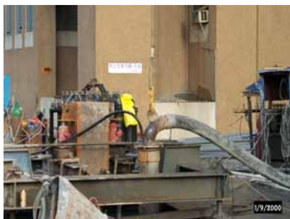
為提昇基樁承载力，減少日後樁尖沉陷，因此基樁底部淤泥，必須事先清除 (air lift)。
