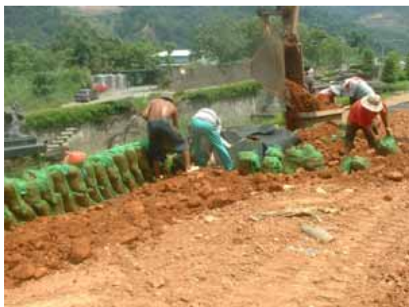
擋土包裝填完畢後封袋口, 於準線後 方堆疊(約 30cm 高)。
