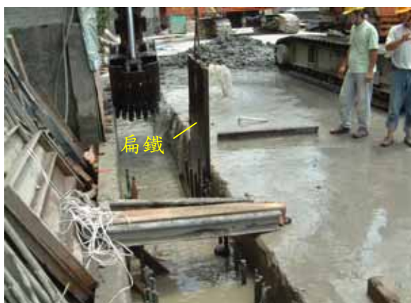
混凝土保護層範圍端版之泥膜利用扁鐵清洗
