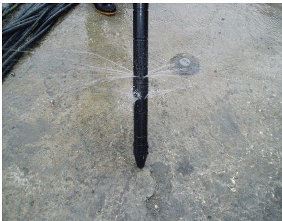
低壓灌漿：由外灌漿管噴出灌注狀況
