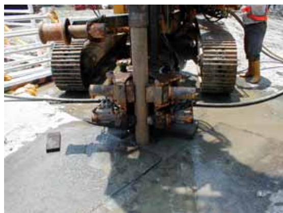
鑽機組裝及定位：利用鑽桿數估計鑽孔 深度（每根鑽桿 2m）
