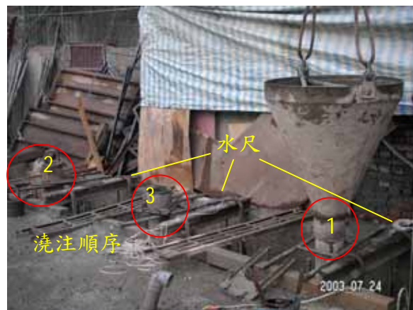
連續壁單元分三點，以特密管平均澆注混凝土。
