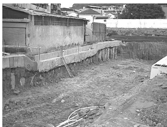
壓樑施做完成，且與 RC 排樁結合為一 體，也可阻擋地面水流入開挖面
