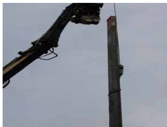
打樁機僅能一次拔起 15m 長之鋼板樁，而圖中鋼板樁長 16m，所以用吊索輔助輔助拔除
