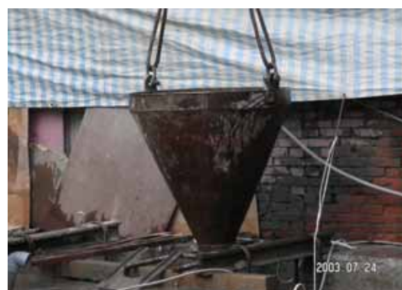
特密管頂端安裝漏斗準備灌漿
