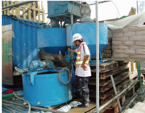
低壓灌漿：CB 漿灌注設備
