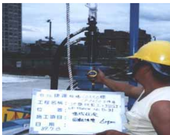
灌漿參數檢驗：鑽桿迴轉速度測定(碼錶)
