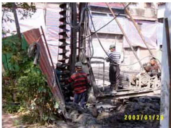
樁體連續垂直鑽挖，直至預定深度
