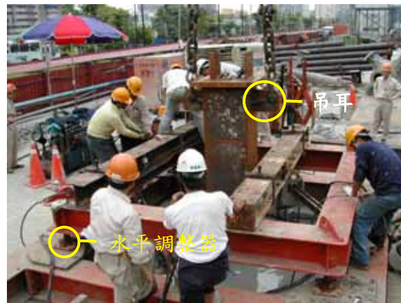
逆打真柱吊放臨時固定，利用鋼柱自重使其垂直於水平面
