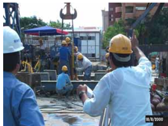
逆打鋼柱高程檢測，藉由水準儀檢視之，若高程不符，可由吊車調整。
