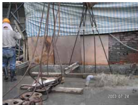
鋼筋籠吊放完成。（陰陽單元）
