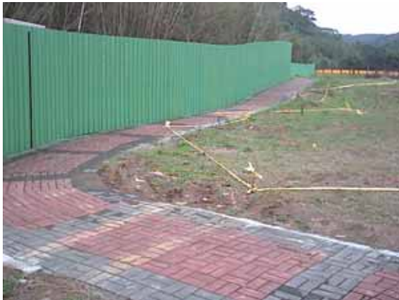
標定鋼軌樁打設的範圍。
