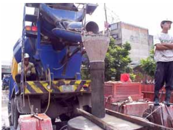
全套管基樁澆置混凝土
