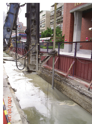
拌合刀鑽至設計深度：利用攪拌翼旋轉，將土壤充分切割擾動，同時使用攪拌翼上之噴嘴噴出水泥漿液
