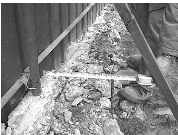
RC 排樁，樁中心放樣位置檢核
