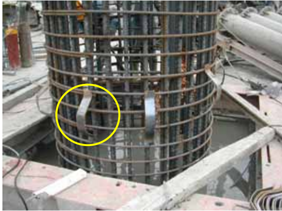
為避免基樁之混凝土保護層厚度不足，於鋼筋籠施作時電焊保護層護耳。
