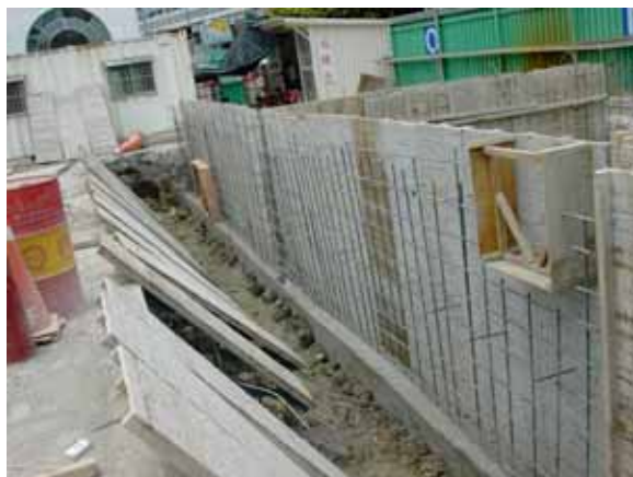
施工中之泥水沉澱池，提供反循環鑽機抽出之泥砂沉澱，經過沉澱之泥水，透過水路回流到鑽孔中，以維持孔內之水位高度並且降低水中含砂量。
