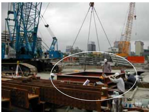
工作架台安裝，用於固定鋼筋籠及調整 逆打柱等作業
