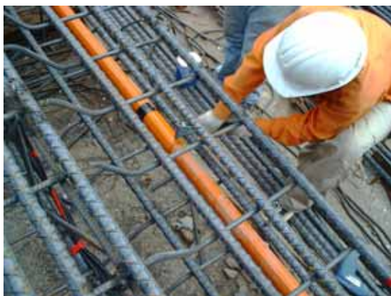
傾度管裝設：傾度管固定在鋼筋籠內
