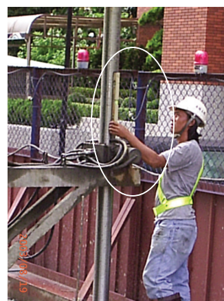
鑽機定位：利用水準器使鑽桿垂直
