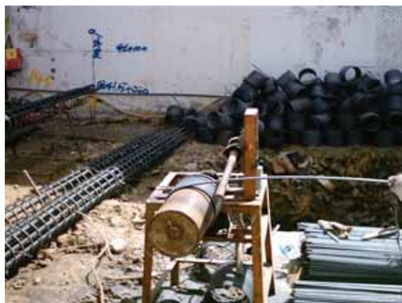
以施工機具施做螺旋箍筋
