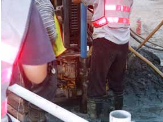
傾度管裝設：置入傾度管過程中，隨時於管內灌滿清水，防止傾度管上浮
