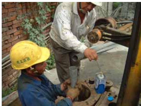
裝設前準備：PVC 管接管時以黏結劑和鉚釘固定之，以確保水密性
