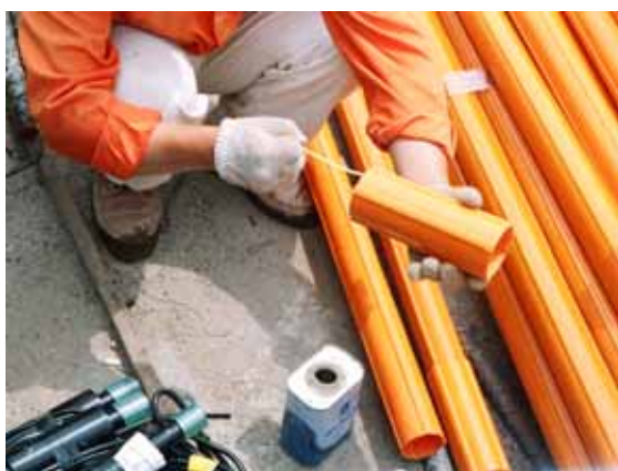
傾度管裝設：連接處塗以凝結膠後套入接頭後再與傾度管續接
