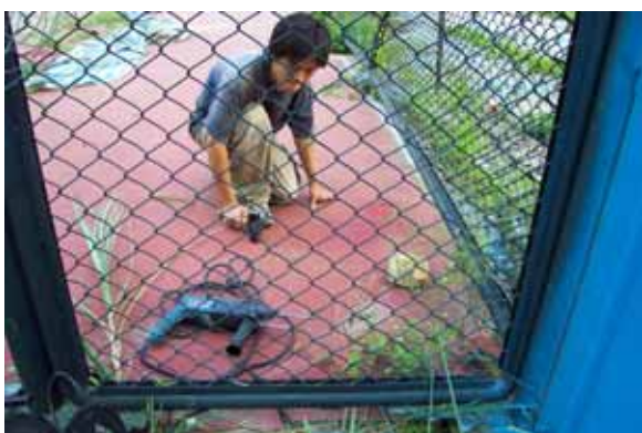
打設安裝：以鐵鎚將地面沉陷釘敲入鋪面點
