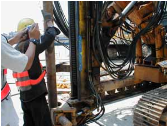
鑽孔及深度檢查：鑽機定位之後，利用水準尺確保鑽機保持水平並開始向下鑽設
