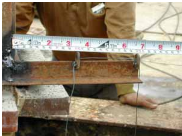
浮筒架安裝，將浮筒架電焊在預定位置，並且量測其長度，與地表面之鉛垂架等長度，利用重力原理檢測逆打鋼柱之垂直度。
