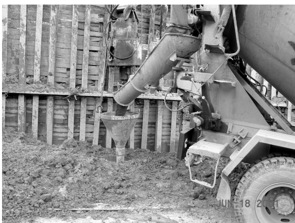
RC 排樁，樁體混凝土澆置
