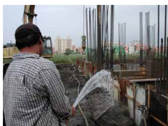
鋼板樁拔除後之孔隙須回填砂，沖水使砂土自然流入孔縫中
