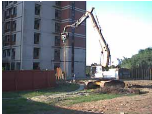
使用打樁機將鋼軌樁打入地盤中。
