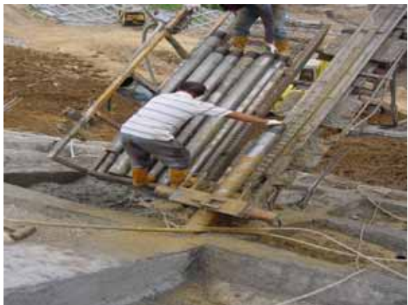
地錨鑽孔配合外套管
