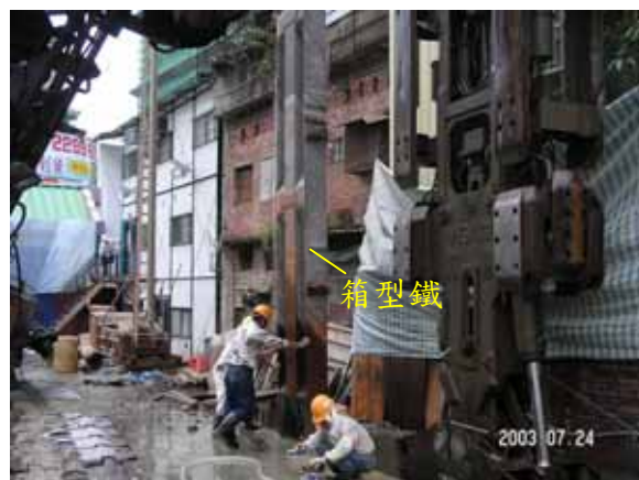
在內外排鋼筋間端版的泥膜及搭接鋼筋的泥膜，利用箱型鐵刷除
