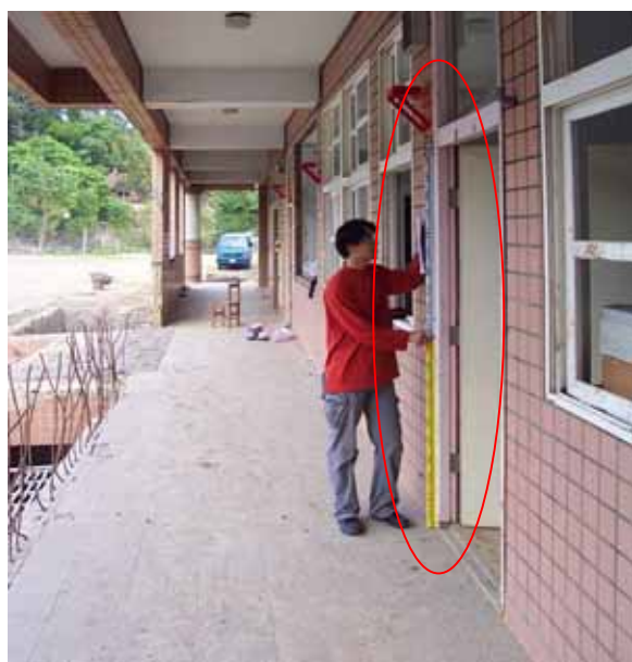
裝設固定架：裝設完後量測其裝設高度
