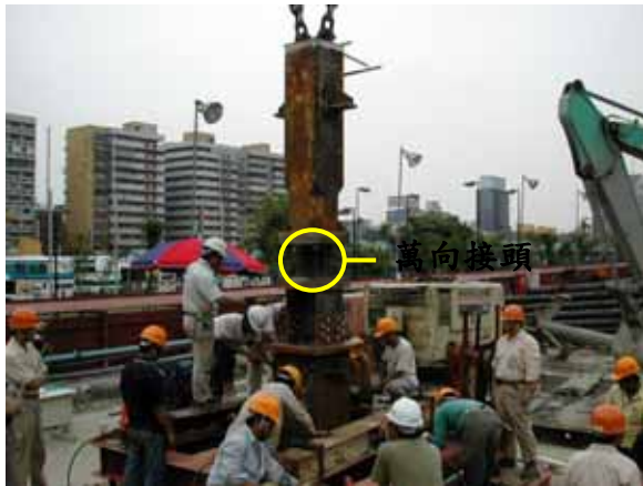
逆打真柱利用萬向接頭與假柱銜接，藉由逆打柱自重使真假柱成一直線，然後才將萬向接頭鎖緊。
