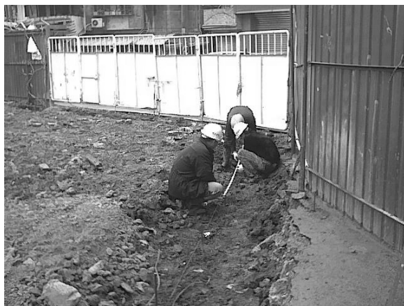
RC 排樁，樁中心放樣並以鋼筋作為標記
