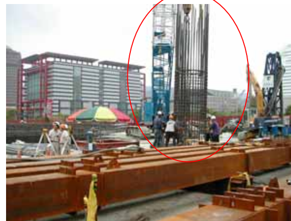
基樁鋼筋籠吊放至預定樁位。
