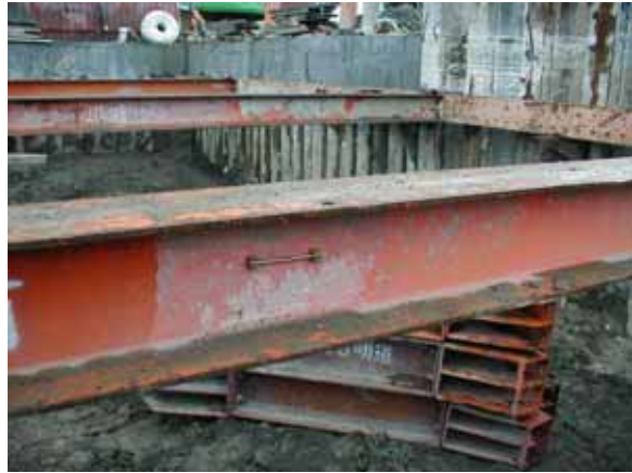
儀器本體裝設：支撐應變計點焊裝設完成
