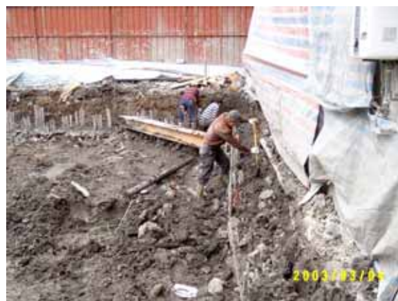
預壘樁頂部敲除及整理，至壓樑預定施 做底部之高程
