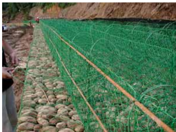
假固定鋼筋於石籠面上，觀察是否產生變形或位移。
