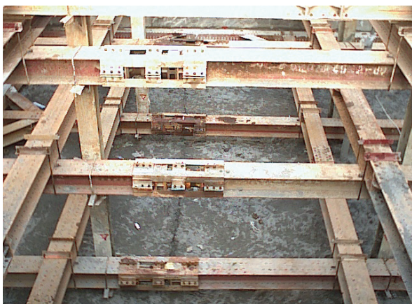
水平支撐必須在不同斷面裝設千斤頂
