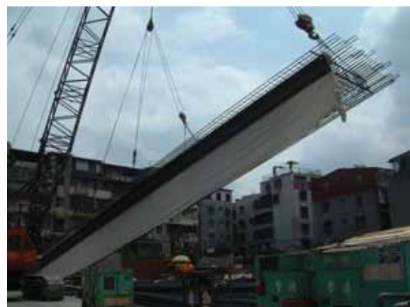
利用吊車將鋼筋籠吊起（陰陽單元）
