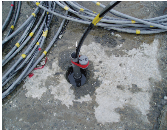
低壓灌漿：內灌漿管，分為灌漿管線、空氣加壓管線
