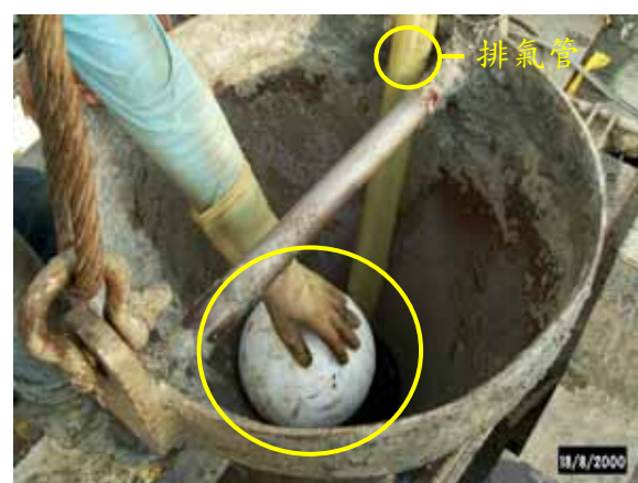
澆置混凝土前，預先在特密管中放置保麗龍球或橡皮碗。
