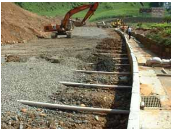
回填厚度約 20cm 之回填土於透水材料 上。
