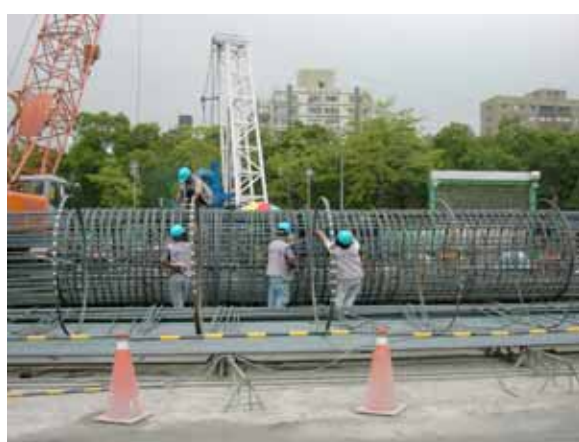
基樁鋼筋籠製作。
