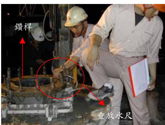
反循環鑽掘機鑽掘完成後，由鑽桿內側垂放水尺確認鑽掘深度是否足夠。
