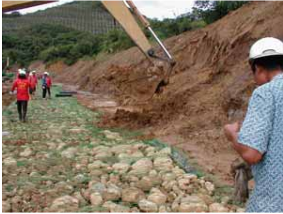
清除地表障礙物,並且整平夯實坡腳基礎。
