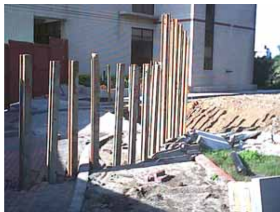
鋼軌樁打入完成。
