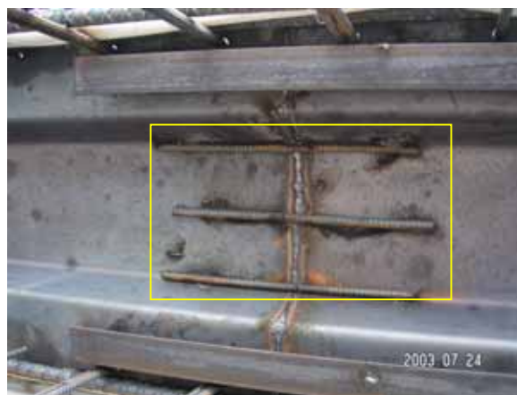
母單元端版焊接處加強電焊補強筋
