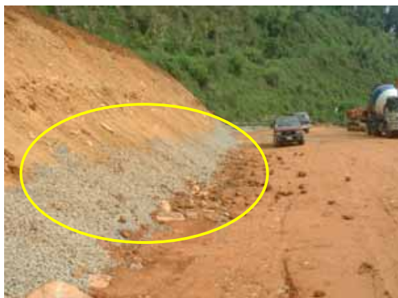
加勁擋土牆後方整面鋪設背填透水碎石(厚度約 30cm)。
