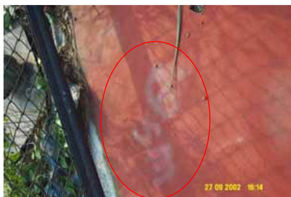
標示記號：使用有編號之鋁牌或噴漆標示鋪面點
