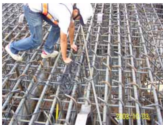
電纜線固定：將電纜線固定於鋼筋籠
