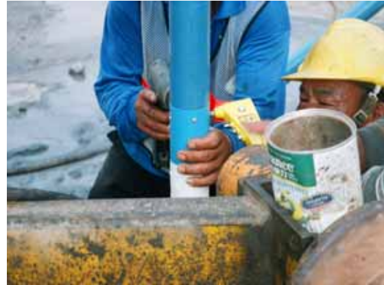
傾度管裝設：續接處打設鉚釘及纏繞防水膠帶固定
