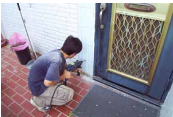
鑽孔及安裝：鑽頭垂直壁面鑽孔，裝設建物沉陷釘
