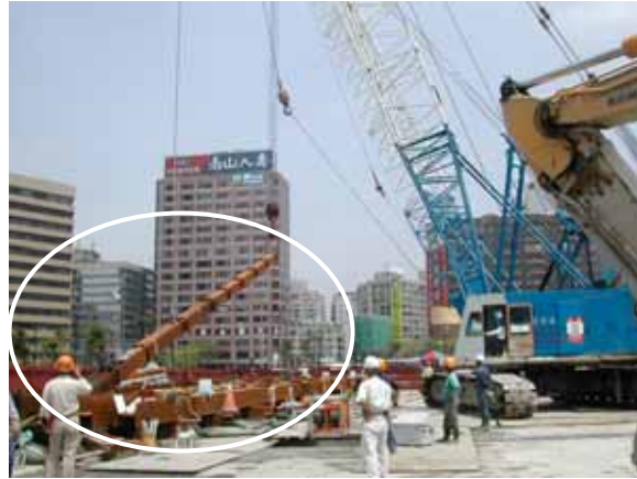
於吊放鋼筋籠後，吊放逆打鋼柱
