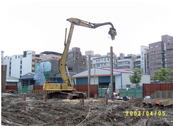
構台樁打設
