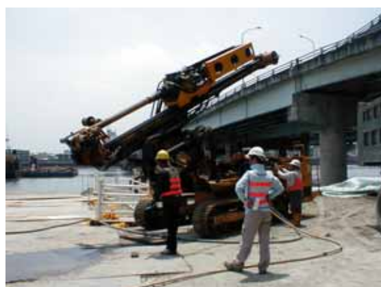
鑽機組裝及定位：鑽機架設
