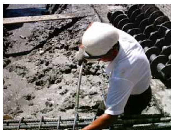
鋼筋籠底部箍緊，使底部形成尖端方便 事後鋼筋籠插入
