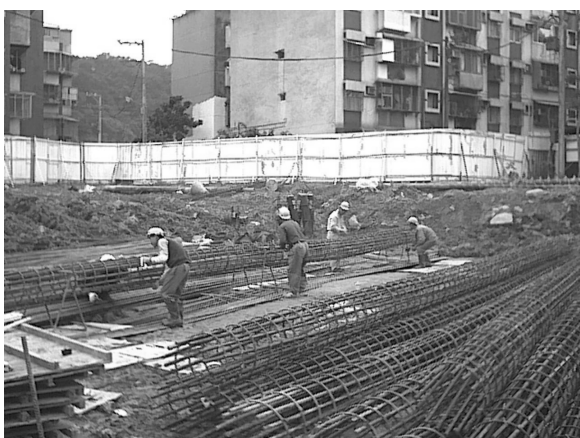
RC 排樁鋼筋籠綁紮
