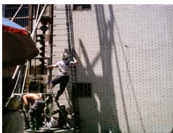
利用吊車將已組立完成之鋼筋籠植入 砂漿樁體內
