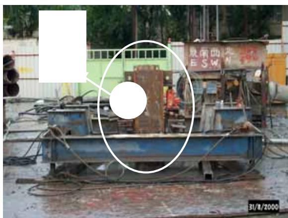
逆打鋼柱吊放完成
