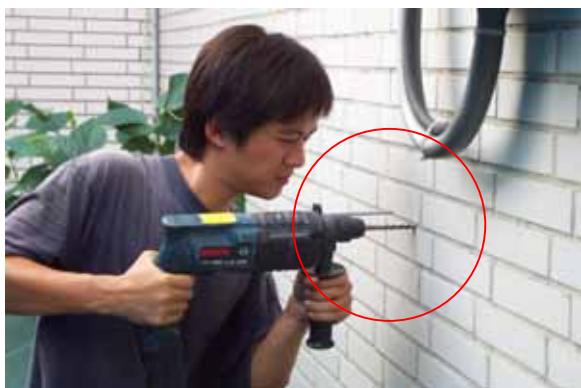
電鑽鑽孔：鑽孔時鑽頭必須垂直壁面
