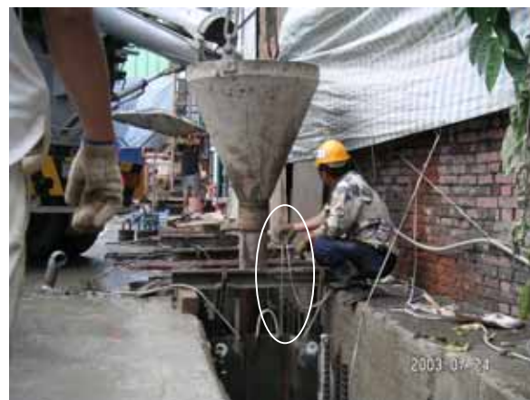
混凝土澆至期間，隨時用水尺量測混凝土澆置高程。
