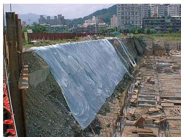
斜坡開挖-鋪設防水帆布，避免雨水冲刷坡面，導致礫石級配變差，產生邊坡坍塌
