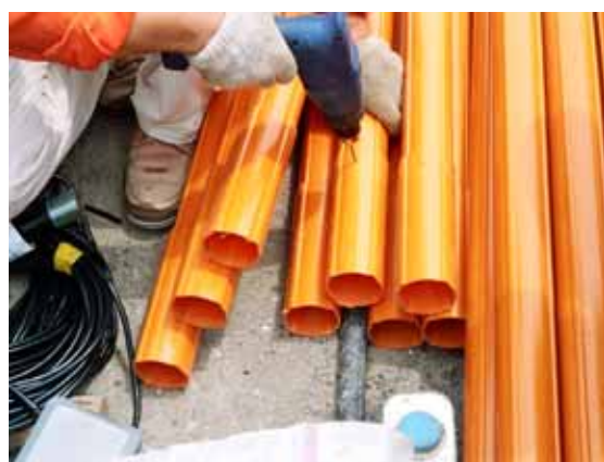
傾度管裝設：續接處打設鉚釘及纏繞防水膠帶固定
