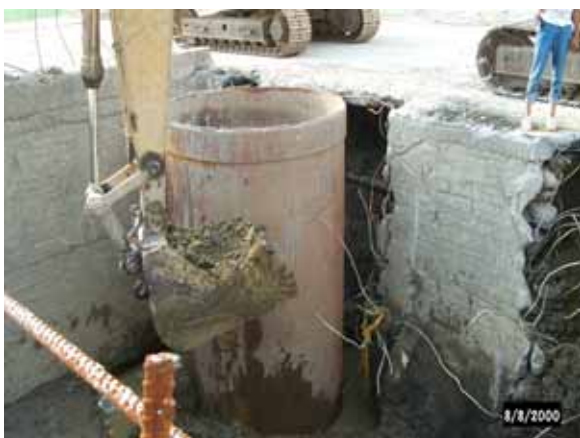
設置沉澱池的位置如有設計基樁，亦應埋設保護套管，並且通過回填土層及容易坍孔區域。
