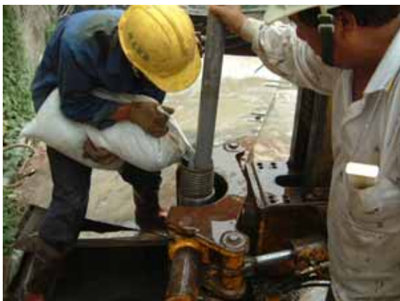
回填與封層：PVC 管裝設完成後，於 PVC 管和套管之間，回填濾材至打孔 PVC 管上 50 公分
