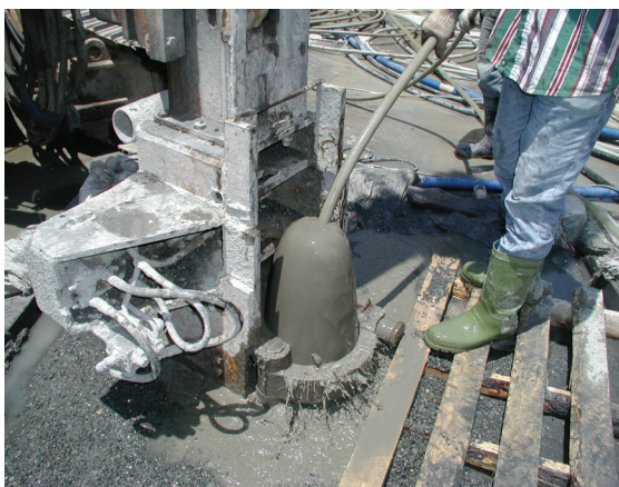
鑽孔至設計深度：灌注封堵材料（CB液）之情形
