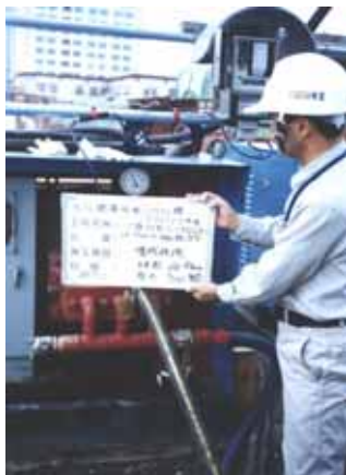
灌漿參數檢驗：灌漿壓力測定（壓力錶）
