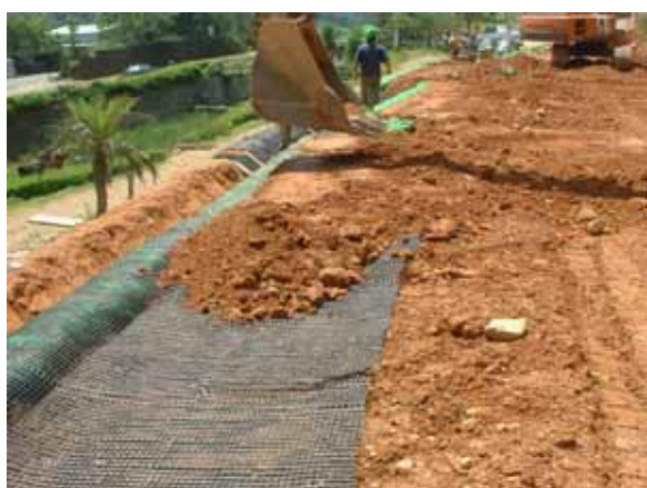
加勁格網向牆內回包, 並且回填鬆 方。
