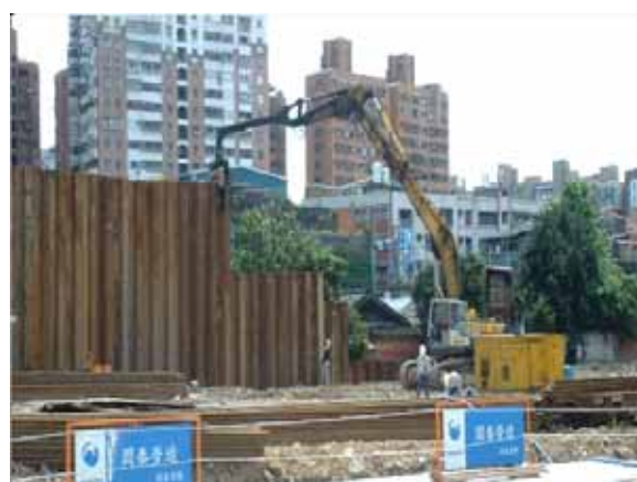
屏風式鋼板樁第二階段打設
