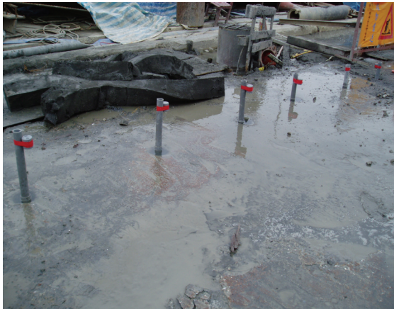
鑽孔至設計深度：安裝外灌漿管完成
