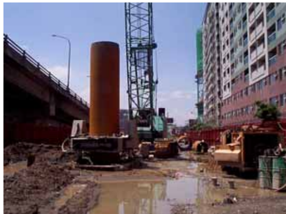
搖管機施工情形
