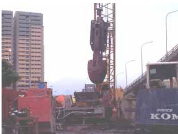
鯊魚頭吊放至鋼套管內之施工情形
