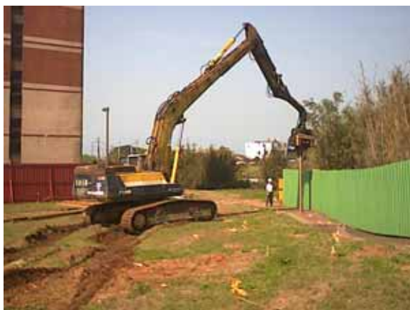
使用打樁機將鋼軌樁打入地盤中。
