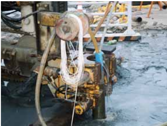
傾度管裝設：於傾度管內持續灌水，防止漿液流入管內
