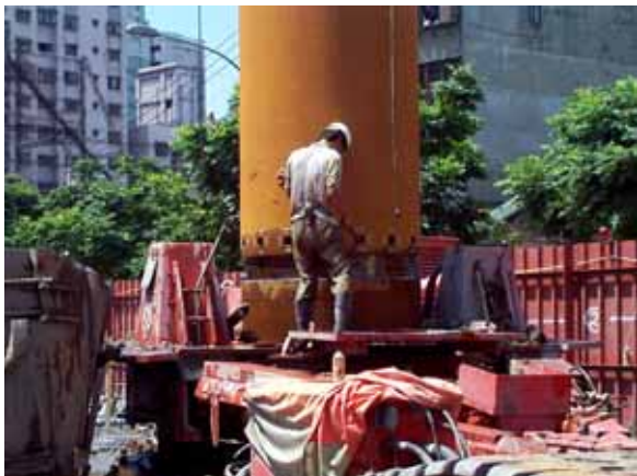
另一種形式之鋼套管接續情形
