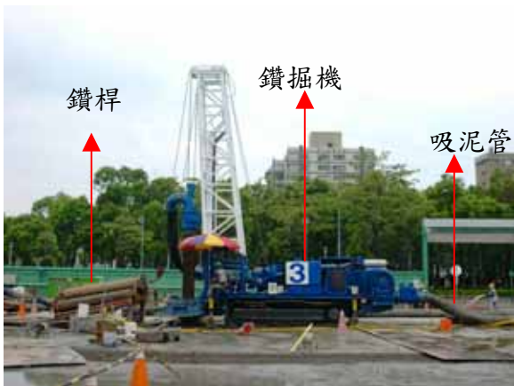
反循環鑽掘機履帶式、反循環鑽桿及吸泥管。
