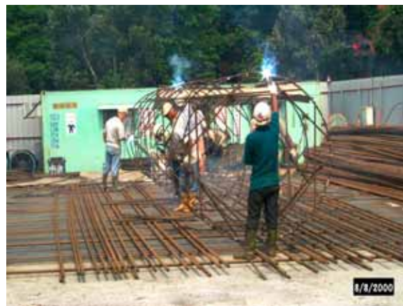
基樁鋼筋籠主筋焊接固定。
