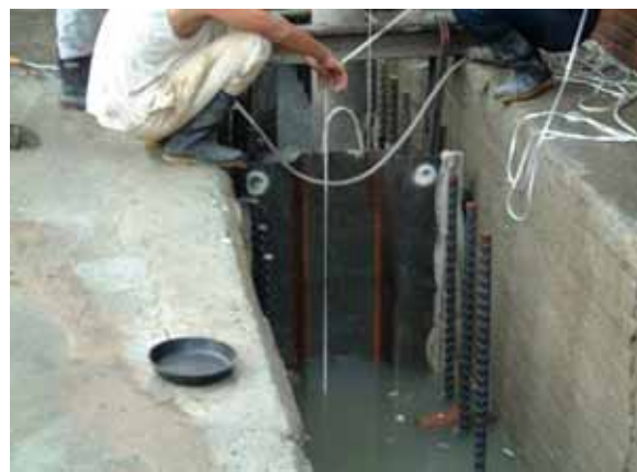
在端版外側利用水尺量測底泥深度，評估是否漏漿
