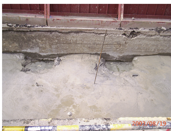
樁體完成：噴射灌漿後表面留下的灌漿孔
