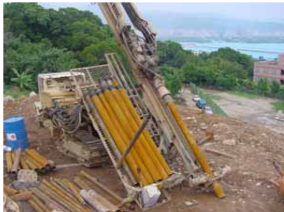
鑽機外套管，用以防止坍孔
