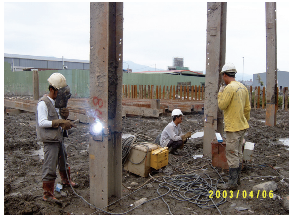
中間柱接樁焊接
