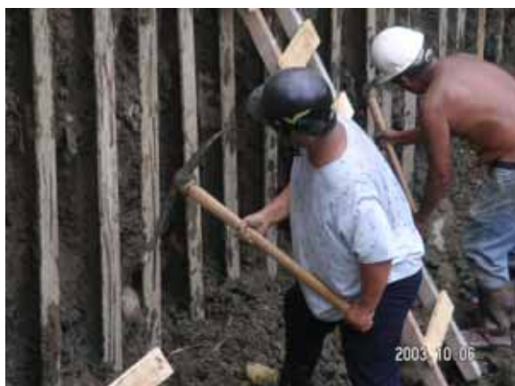
清除鋼軌樁之間的土壤及石塊,準備嵌放橫板條。
