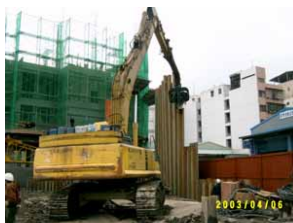
屏風式鋼板樁打設，PC-450 打樁機
