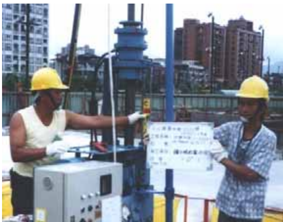
鑽機定位：利用水準器對準垂直度
