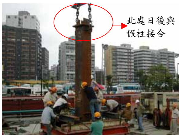
逆打真柱吊放，若非日後需要做樁載重試驗，逆打柱一般低於地表面，真柱上方需加一節假柱銜接之，使後續地面樁位及垂直度可以藉由假柱繼續調校。
