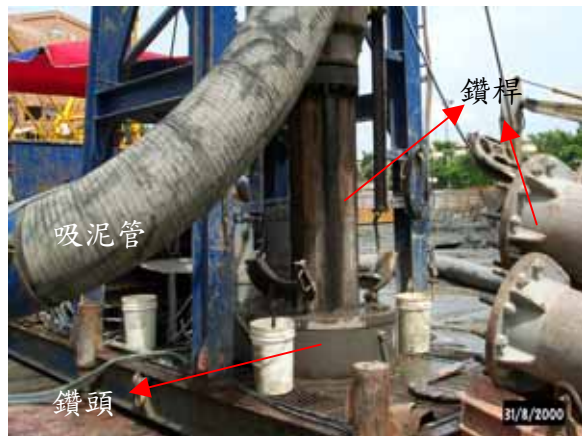
反循環鑽掘施工。
