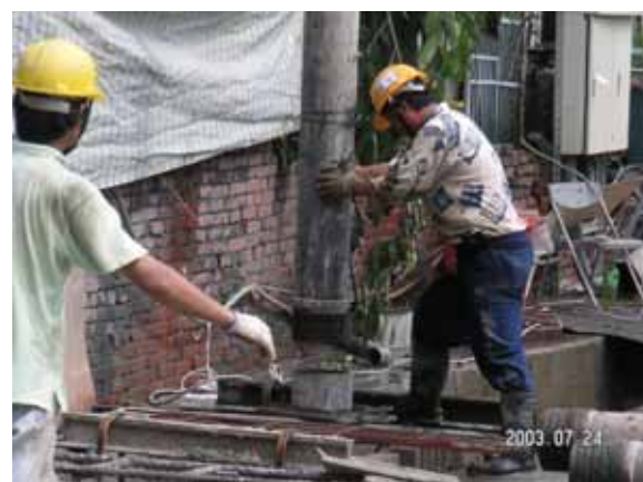
吊放及續接特密管以澆置混凝土
