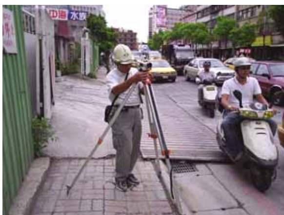
觀測後續值：以水準儀觀測各沉陷釘（過程中需定平）
