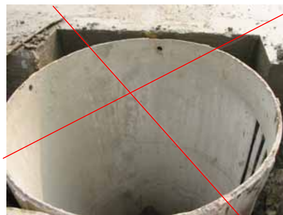
套管理設後，拉線標示基樁之中心線。
