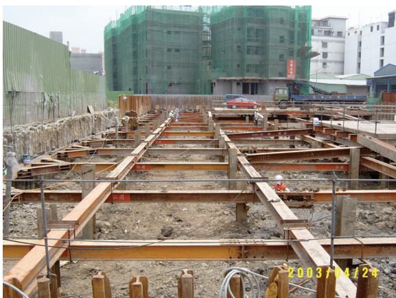
長向水平支撐在短向上方
