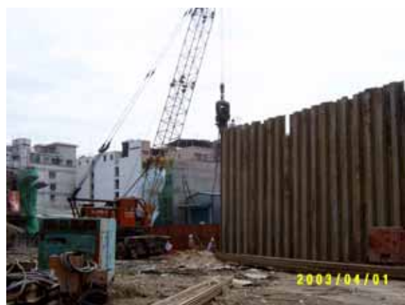
屏風式鋼板樁打設
