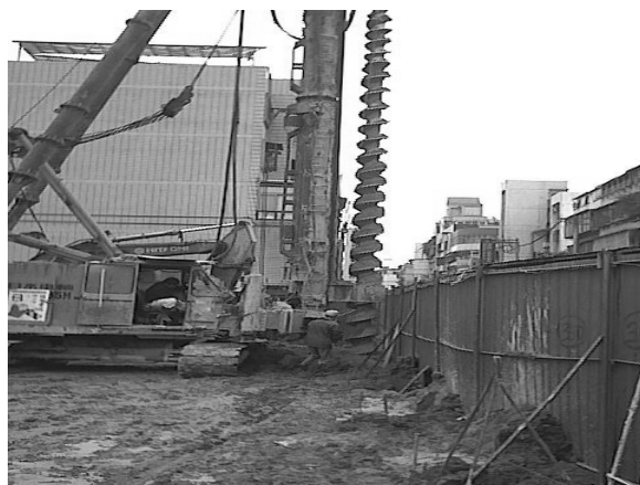
樁體連續垂直鑽挖，直至預定深度
