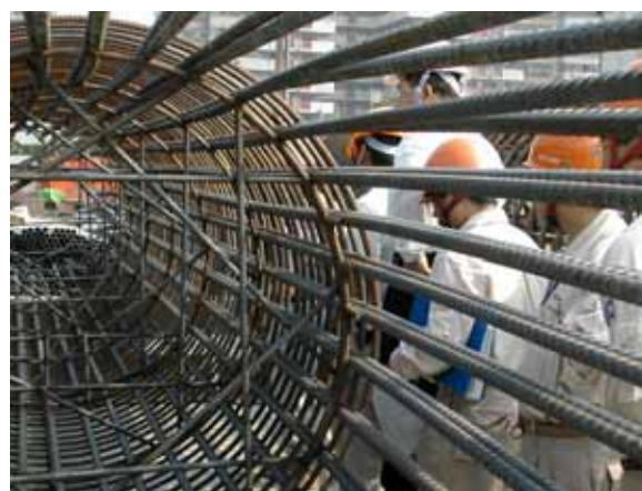
基樁鋼筋籠目視檢查。
