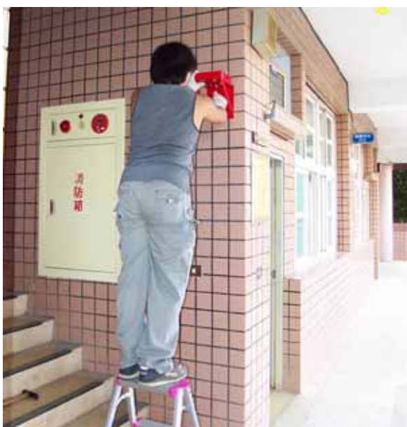
裝設固定架：裝設固定架應保持水平
