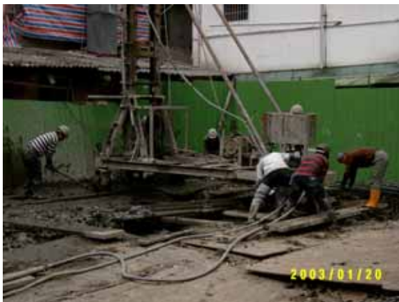
移機定位使螺旋鑽軸心與樁中心一致
