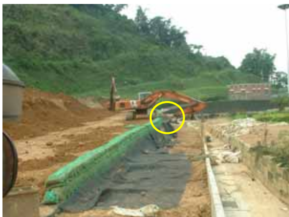
以挖土機前斗壓實並且整平坡面。
