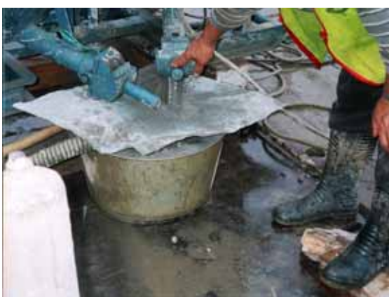
孔壁管間回填：利用篩網過濾未溶解之水泥或皂土
