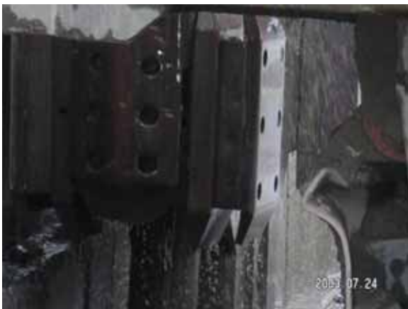
挖掘機抓掘連續壁單元之土壤
