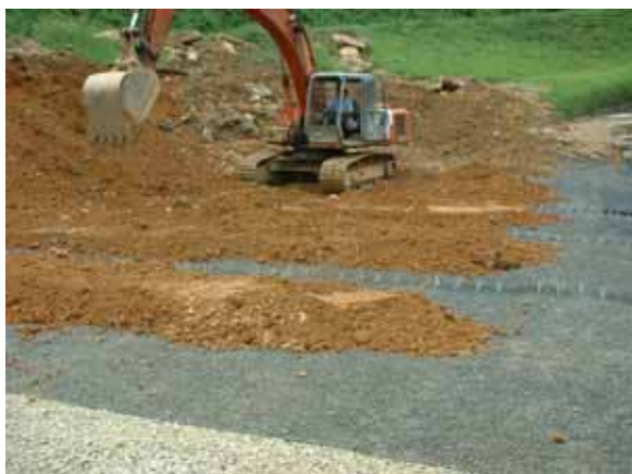
回填鬆方於加勁格網上 (厚度不得超過 30cm)
