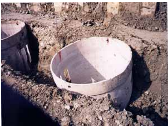
反循環基樁施工前，防止崩孔之套管理設，一般套管長度需深於回填土層或通過易坍孔區。
