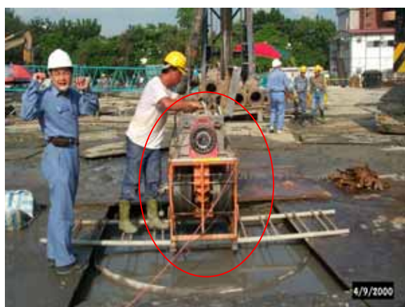
鑽孔完成後，須以超音波檢測坍孔情形。
