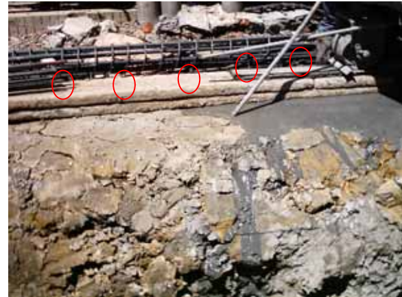
在樁中心線外架設木板，並於木板上釘上鐵釘作為樁中心點
