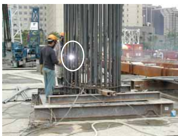
上下兩段鋼筋籠搭接處現場焊接。
