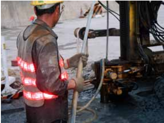
孔壁管間回填：將塑膠管慢慢由孔底向上拔昇
