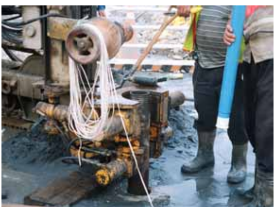
鑽機組裝及定位：利用水尺確認鑽孔深度
