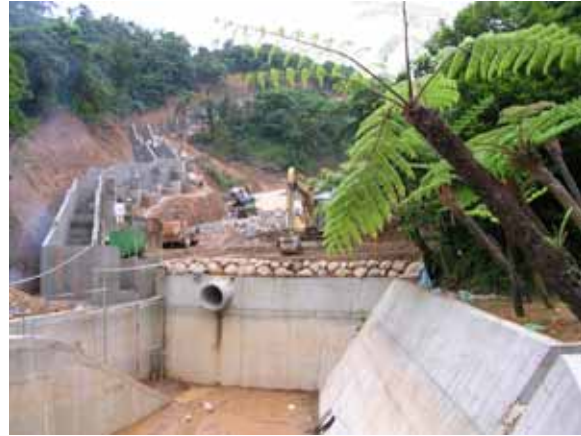
擋土牆基礎夯實,並且做現場工地密度試驗。
