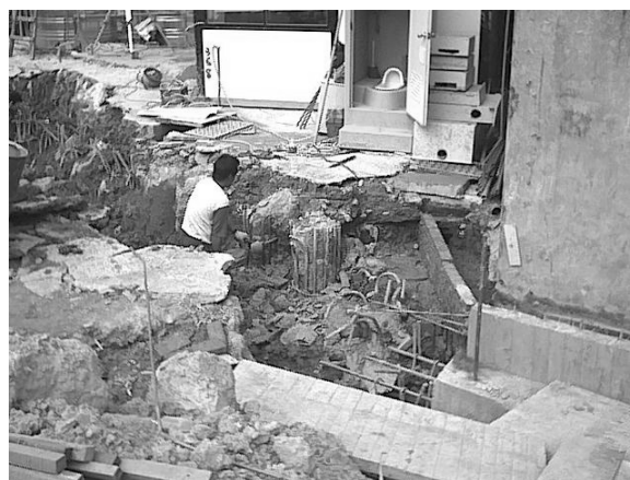
RC 排樁頂部敲除及整理至壓樑預定施 做底部之高程
