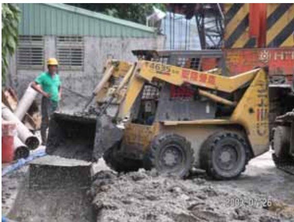
將粘土倒入開挖壁面，並且攪拌使粘土吸水膨脹並懸浮，以達到穩定壁體內外土水壓力之目的，與加入蒙脫土有類似的效果
