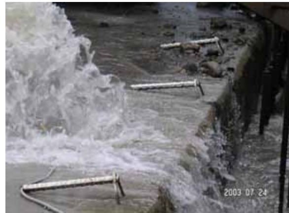
爲保持連續壁導溝內之水位，壁體開挖期間須抽水補注由導溝流失之地下水
