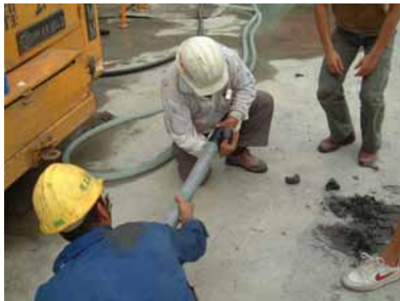
裝設前準備：PVC 管置入前先行打孔，並且包覆濾網
