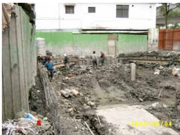
壓樑鋼筋綁紮
