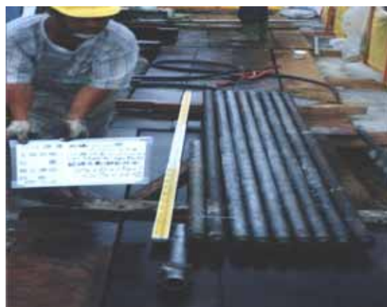
拔管清洗：灌漿後拔除套管並清洗
