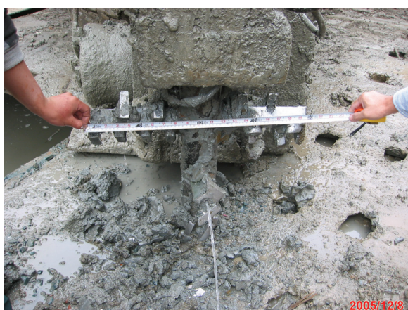
拔桿清洗：利用高壓水沖洗灌漿管
