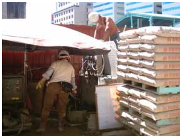
符合合約規定之配比，拌和水泥砂漿
