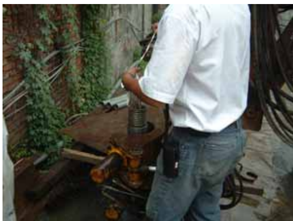
回填與封層：利用水尺量測深度，並準備拔除套管
