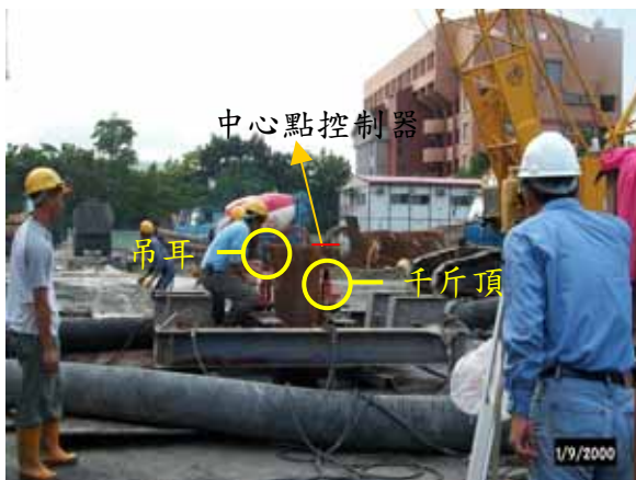
鋼柱定位檢測，利用經緯儀檢視逆打柱有無旋轉或偏移，並配合水準儀檢視逆打柱高程。
