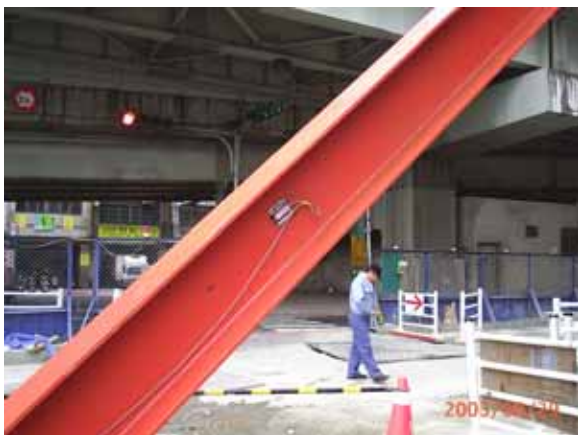
儀器本體裝設：支撐應變計裝設於斜撐情形
