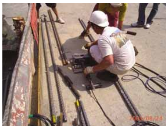
鋼筋計接合：將鋼筋計壓接於欲裝設之主筋
