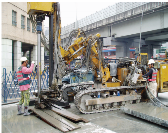
鑽機定位：利用水準器調整鑽桿角度
