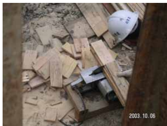
橫板條依鋼軌樁打設之間距切割合適的寬度。
