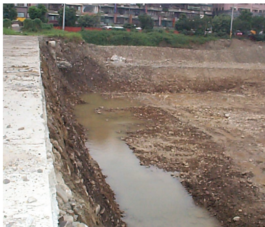
斜坡開挖之臨時導水溝
