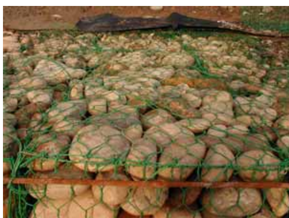
綁紮主邊框線（間隔約 25cm 固結一次）。
