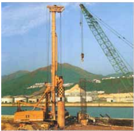
土鑽工法施工機具
