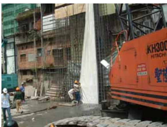
吊放鋼筋籠（陰陽單元）
