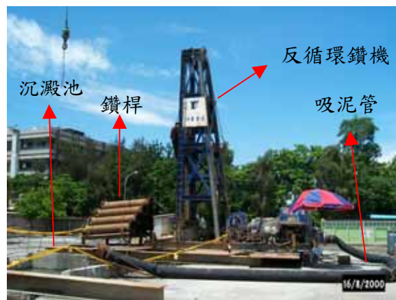
反循環鑽掘機平底式、反循環鑽桿、吸泥管及沉澱池。
