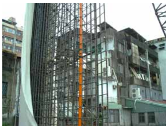
傾度管裝設：鋼筋籠吊放
