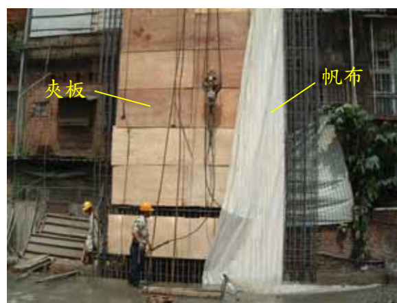
吊放鋼筋籠，因為超音波檢測發現坍孔嚴重，所以連續壁開挖內側預先安置夾板，有助於敲除超灌注的混凝土（陰陽單元）
