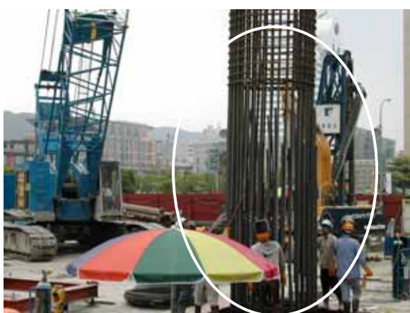
鋼筋籠吊放，因基樁長度較長所以需要 搭接兩段鋼筋籠。
