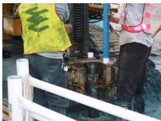
傾度管裝設：確定深度後，準備放入傾 度管
