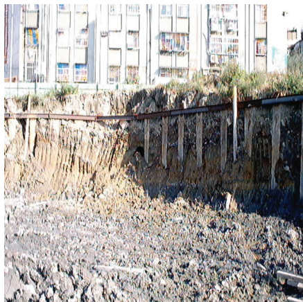
順打工法第一階土方開挖 (擋土設施為鋼軌樁)
