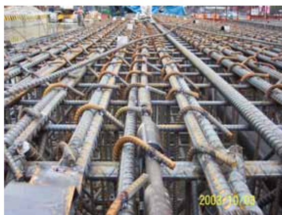
鋼筋籠主筋電焊固定：將安裝鋼筋計之主 筋電焊於鋼筋籠
