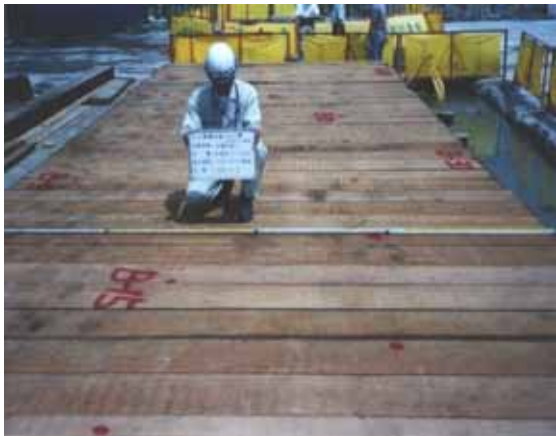
測量放樣：在廢土坑上構築施工台架，用噴漆在構台上標示灌漿孔位
