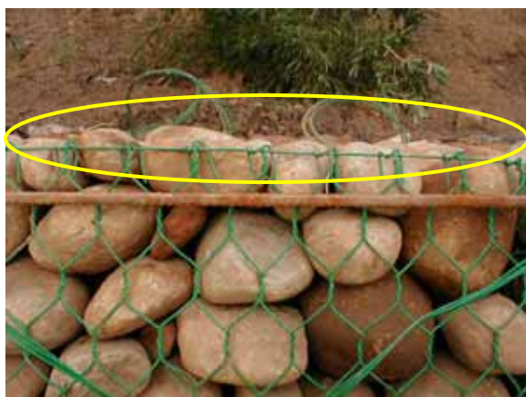
封蓋前，使石面高於籠頂約 5cm，避免將來沉陷導致石籠變形。
