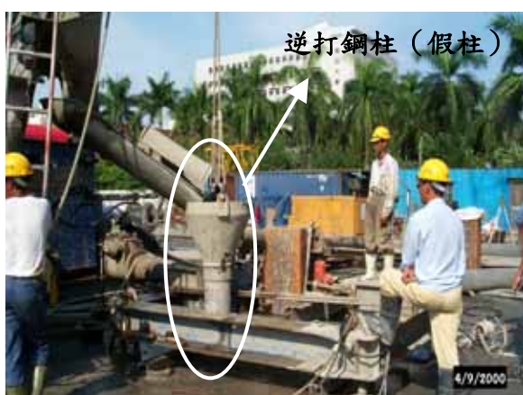
基樁混凝土澆置。
