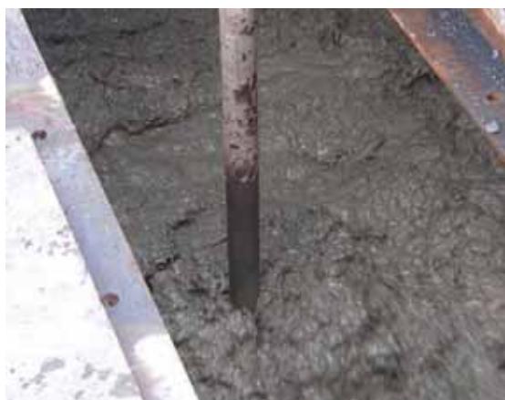
灌注水泥漿：高壓噴射狀況
