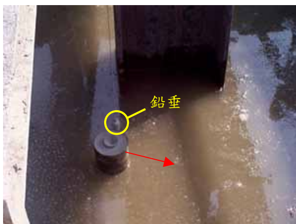
逆打柱吊放浮筒及鉛垂校正，當浮筒及鉛垂成一條直線時，表示逆打鋼柱上下兩端均垂直於水平面，如果沒有呈一直線，可藉由四具水中千斤頂調整。
