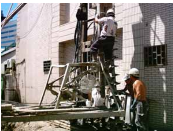
鑽桿搭接，使之連續垂直鑽挖
